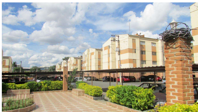
Foto 01 – Vista geral do Condomínio Residencial Borba Gato.
