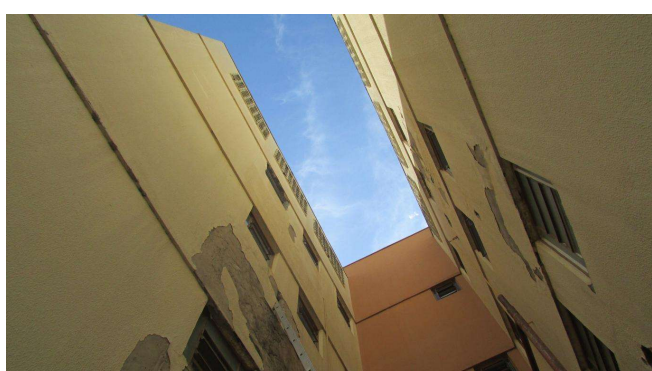
Foto 05 – Vista geral do Condomínio Residencial Borba Gato.
